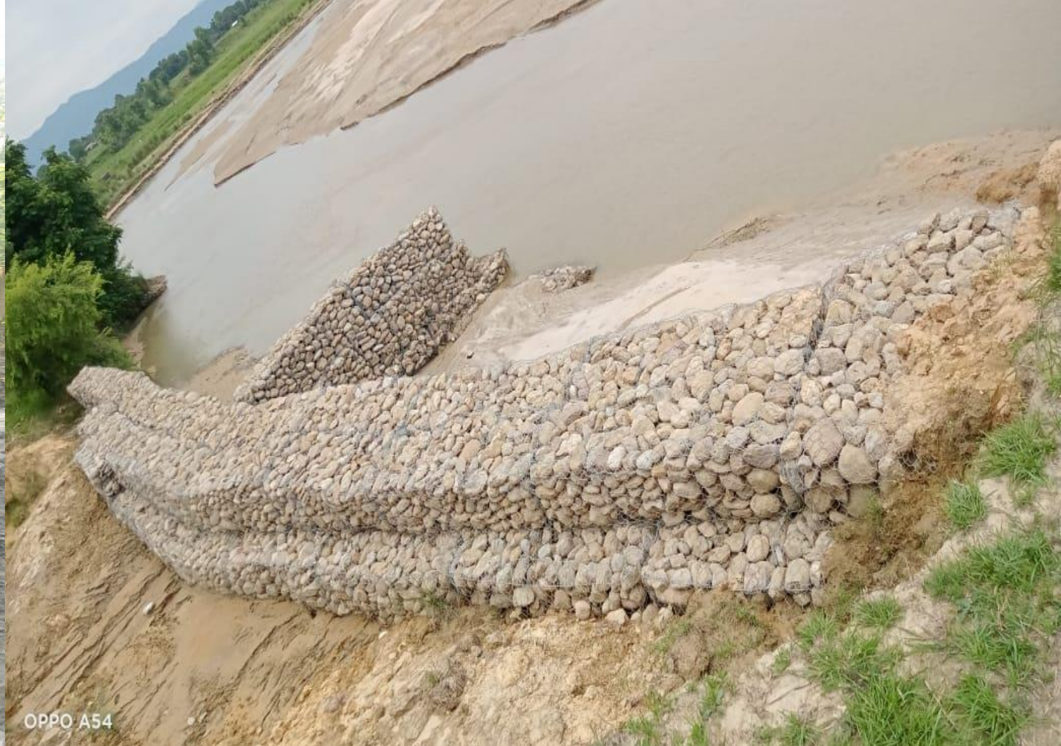
थरौली चिराई खोलामा तटबन्ध निर्माण
