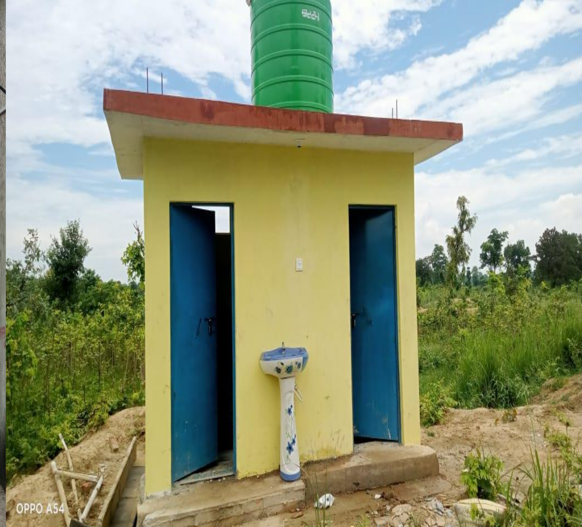
बनखेतमा सार्वजनिक शौचालय निर्माण
